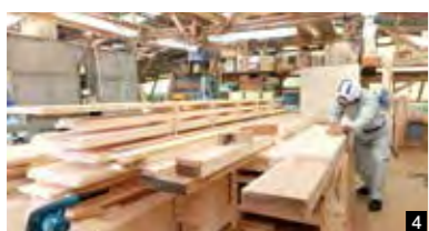
1 礎石に建てられた柱の木口は、石の細かなカーブに沿うように細工され、まるで木と石が一体化しているよう！ 2 「根継」された材。 3 以前の修理の際に記されたどの位置の材かを示す墨書き。 4 カンナ掛けの様子を拝見。ちなみに長福寺の現場にいる2人の宮大工は奈良県職員。奈良県は全国でも珍しく、公務員として宮大工を採用しています。工事終了予定は平成28年夏頃。
