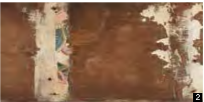
1 初重の解体作業中の東塔。解体箇所が下に行くに従い、支えてきた重さの桁外れさを示す傷み具合が明らかに。中央に見えるのが「心柱」。 2 解体調査中に見つかった初重の天井に描かれた宝相華(ほうそうげ)。格子で隠れた部分に、創建当初の文様の色彩が退色することなく残っていました。
