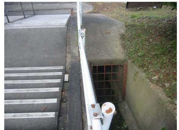
「暗渠」の入り口
