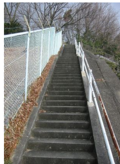
給水塔の傍にある丘に続く コンクリートの階段
