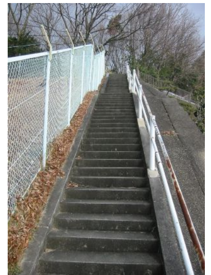
給水塔の傍にある丘に続くコンクリートの階段
