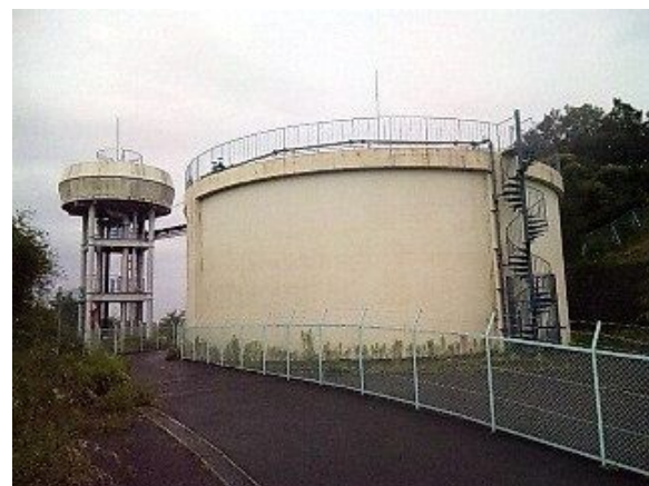
「いぐいぐブログ・2」さんのHPより <右が「配水地」、左が「高架水槽」>
